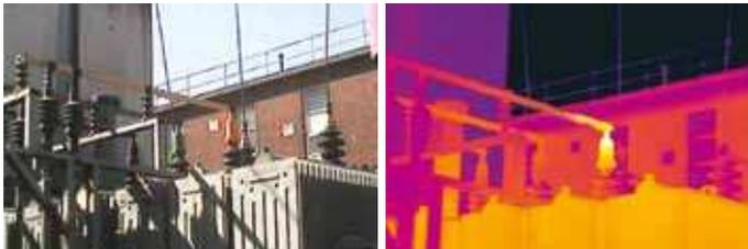
*Una visión amplia de una subestación puede mostrar rápidamente las zonas en las que existen conexiones de alta resistencia no deseadas. Ninguna otra tecnología de mantenimiento predictivo es tan eficaz para las inspecciones eléctricas como la termografía.*
