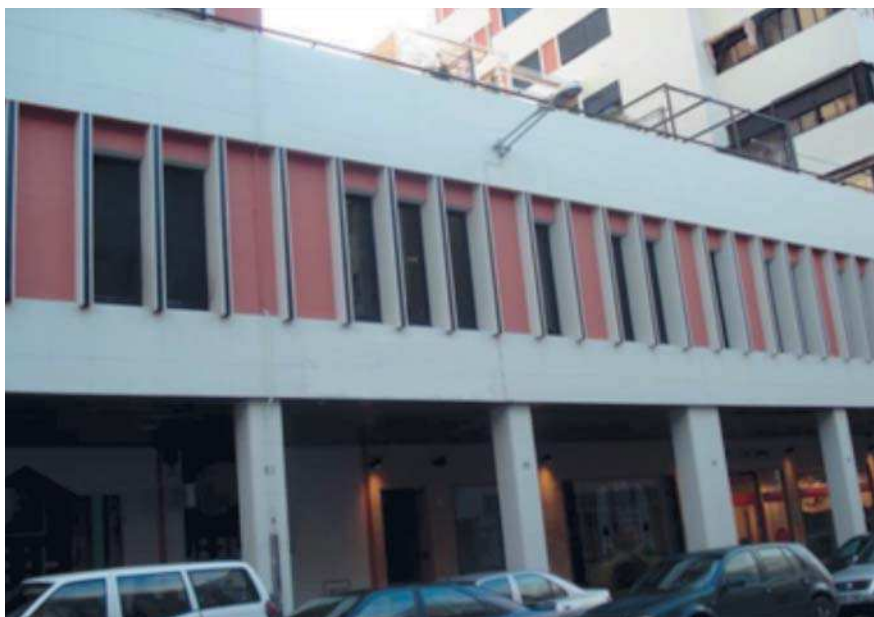
Fotografía 1. Fachada principal del edificio.
