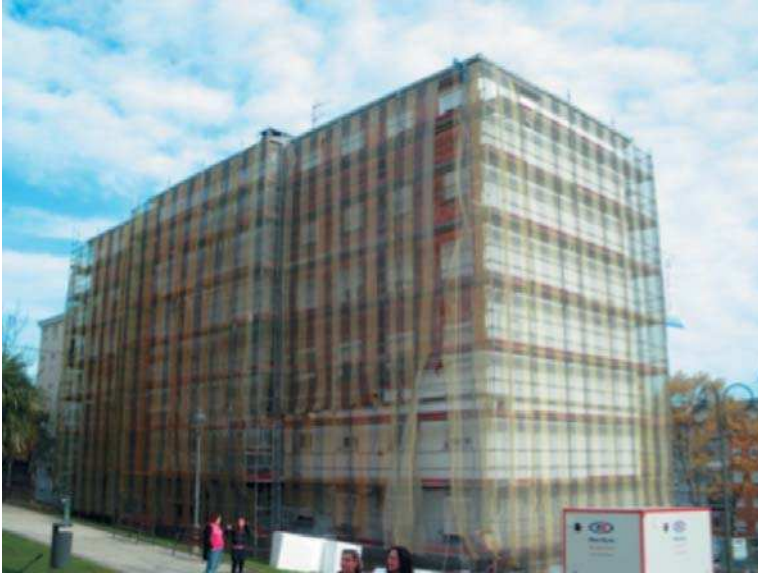
Fotografía 3. Andamios colocados por el exterior de los edificios permiten la realización rápida de los trabajos necesarios.
