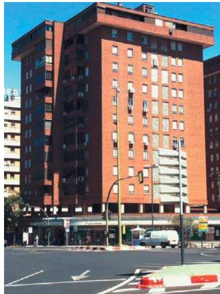
Fotografía 1. Vista de una de las tres torres del edificio de viviendas objeto de estudio. Fachada Sur - Suroeste recibiendo la luz del sol y fachada Oeste - Noroeste en sombra.
