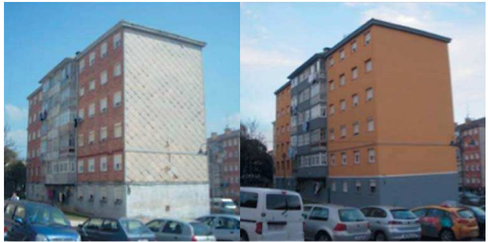
Fotografía 2. Antes y después de la rehabilitación térmica.
