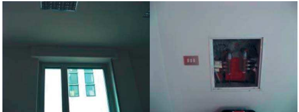
Fotografía 5. Ventana con caja de persiana.
