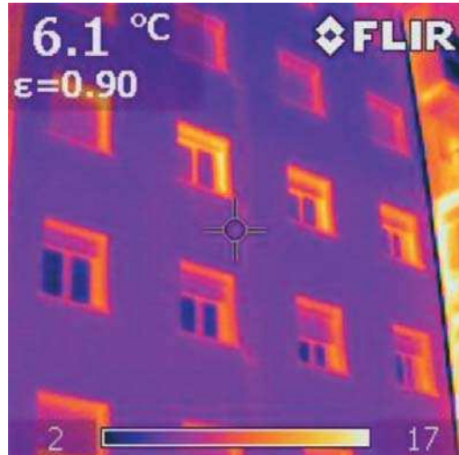
Figura 3. Rehabilitación térmica con el sistema Rhonatherm.
