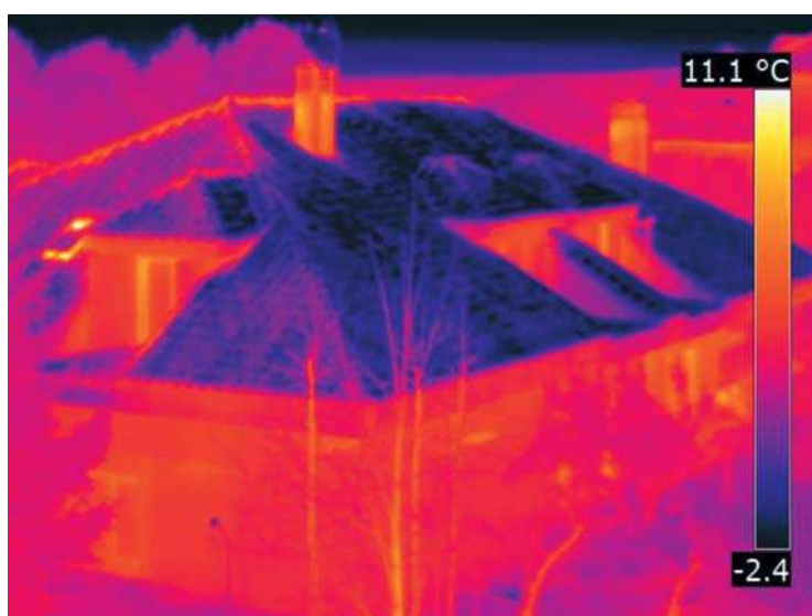
Figura 12. Imagen infrarroja del exterior de una vivienda.
