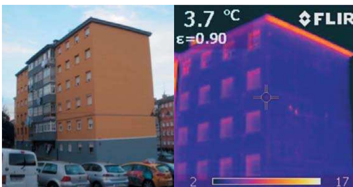
Figura 6. Imagen digital y térmica tomada en el exterior de un edificio aislado térmicamente.
