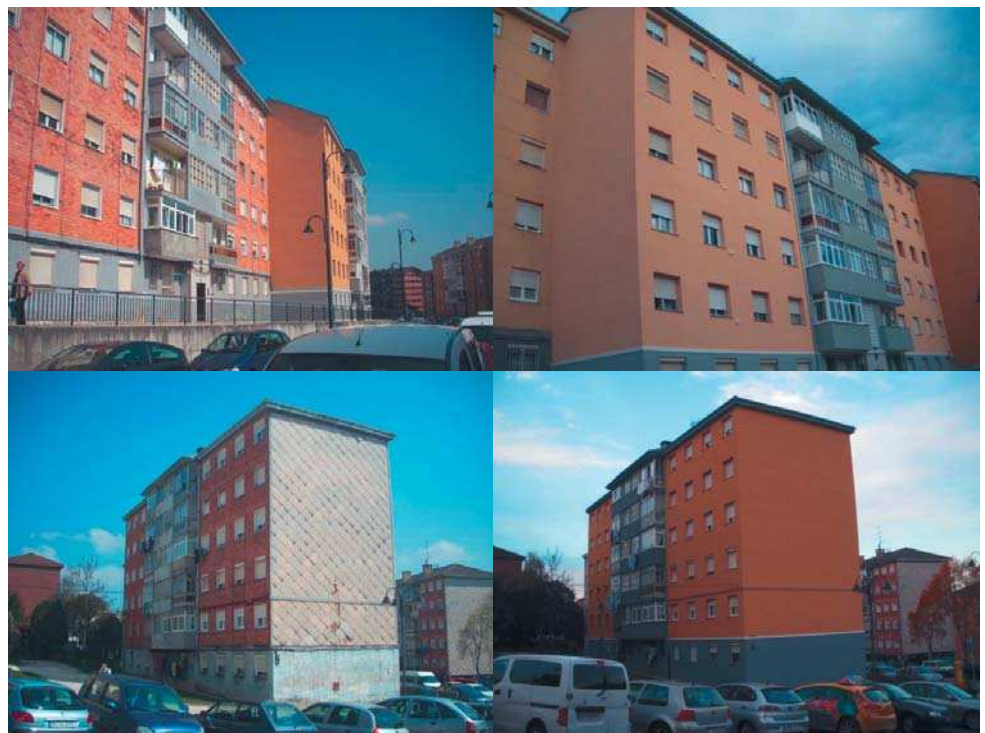
Fotografías 7. Fotografías del antes y después de algunos de los edificios rehabilitados con Rhonatherm.
